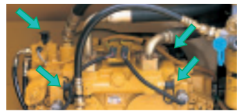
ポンプなど各所に設置された 圧力検出タップ
