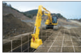
ICT 建機の刃先データ
